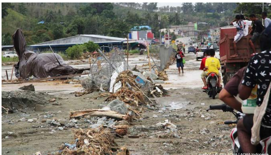
Schäden in Ostindonesien © Foto: ADRA Indonesien
