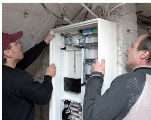
Erneuerung des Zählerplatzes
