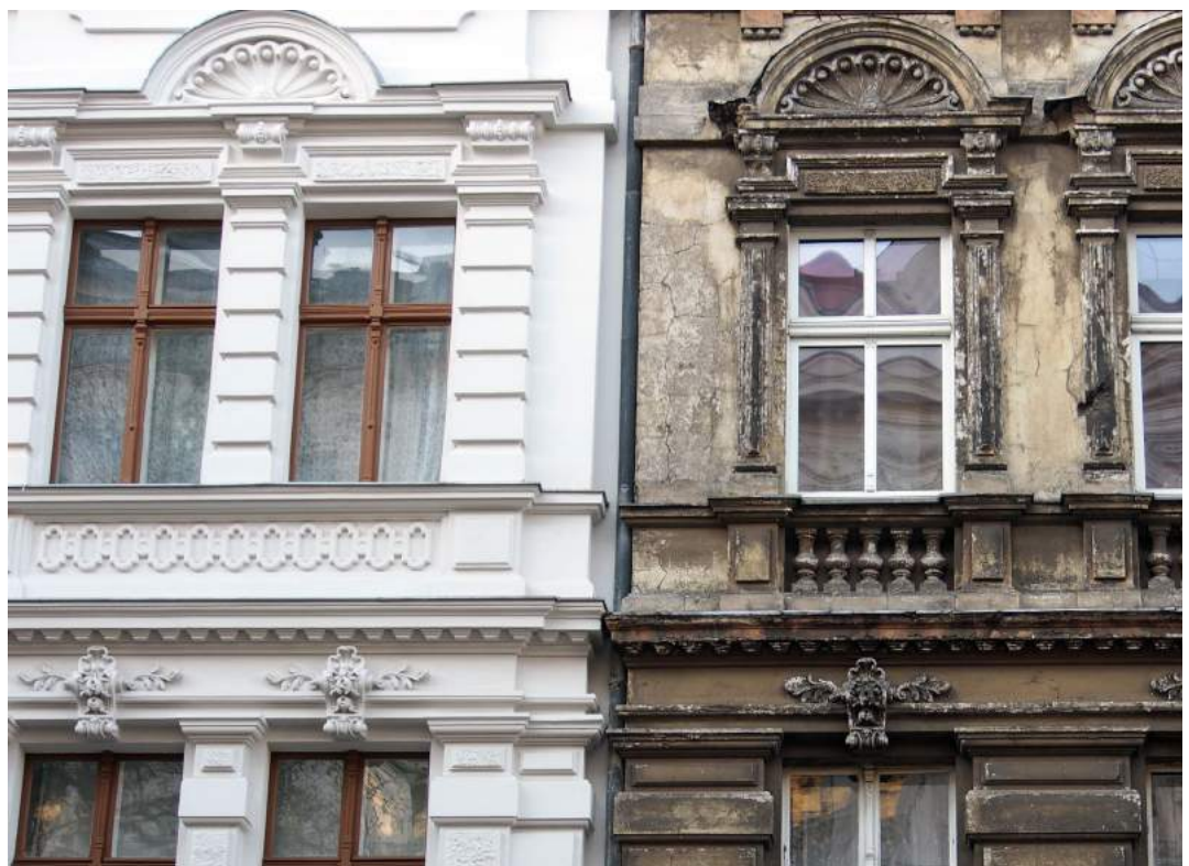
Bei einer Sanierung sollte die Elektroinstallation nicht vergessen werden.
